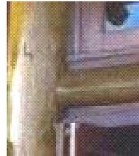
Conexão da viga, através de entalhe normal à coluna.
