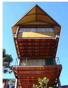
Vigas com seção composta por dois elementos.
