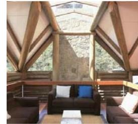
Nas logs tradicionais, as próprias paredes apóiam o telhado. Como este projeto é muito recortado, com clarabóia e painéis de vidro, foi preciso acrescentar pórticos e colunas.
