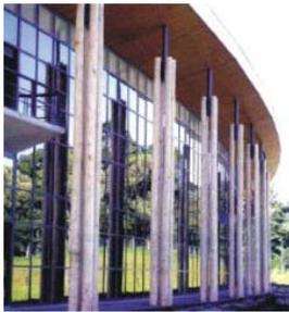
Detalhe da interface no topo das colunas de eucalipto com a estrutura metálica com perfis tubulares, circular apoiando a cobertura do edifício.
