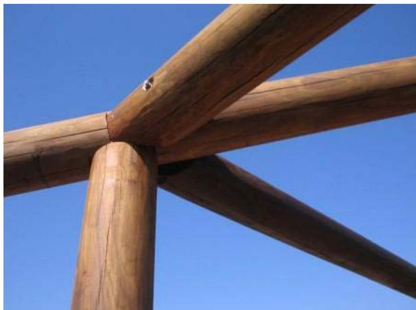
Encontro de vigas laterais e espigão. Foi usado um martelete para o espigão e barra rosqueada Ø1/2" para as vigas de travamento laterais.
