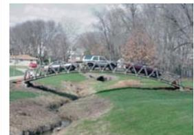
Prova de carga da passarela, com três veículos, sedo que no vão central o veículo é um furgão.
