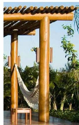
Viga apoiada sobre o entalhe no topo da coluna.
