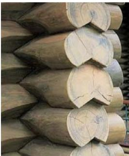
Entre os troncos sobrepostos, aplica-se uma espuma de vedação, que evita o surgimento de fendas. Para reforçar a junção, são instalados parafusos longos em toda a extensão da parede passando pelas toras.
