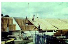
Montagem da estrutura do piso da arquibancada.
