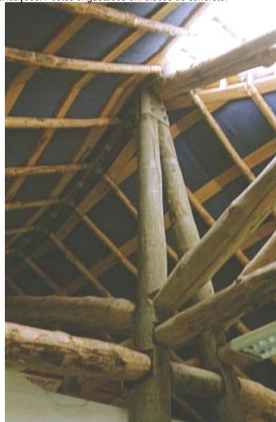
Detalhes das conexões do pórtico, nas colunas inclinadas V invertido.
