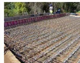
Conectores e malhas de aço, instalados sobre a estrutura de madeira do tabuleiro.
