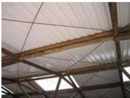
Detalhe da grelha de vigas de dupla seção com peças roliças de pequeno diâmetro e dos tirantes de aço de 16mm.
