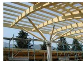
Vista completa de um sistema de escoramento definitivo da estrutura da cobertura.
