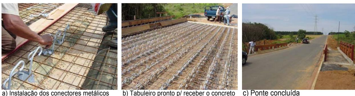
a) Instalação dos conectores metálicos    b) Tabuleiro pronto p/ receber o concreto    c) Ponte concluída
