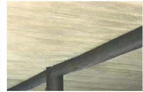
Estrutura da laje de concreto pré-moldado, apoiada sobre às vigas de madeira roliça de eucalipto.
