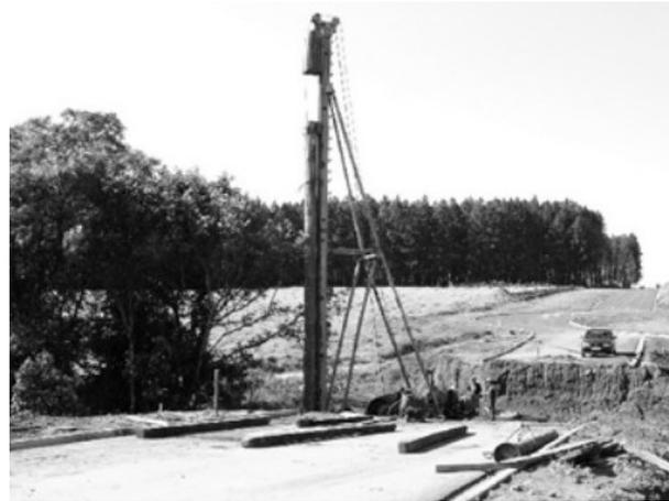
Equipamento de bate-estacas: martelo, capacete.
