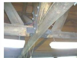
Conexões com chapas externas, dos nós da treliça do banzo inferior, com as diagonais, montantes e consoles que recebem às extremidades das peças de contraventamentos.
