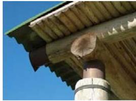
Conexão das ligações viga-coluna. O forro do pavimento superior é formado por semitoras de madeira roliça de pequeno diâmetro.
