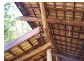
Vista frontal das 2 vigas inclinadas que suportam o beiral c/ balanço de 3,5m.
