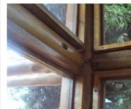
Sistema de instalação dos vidros da fachada com sarrafos fixados nas peças roliças.
