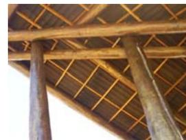
Conexões na ligação das duas vigas inclinadas principais, no topo da cobertura, junto ao topo das duas colunas.
