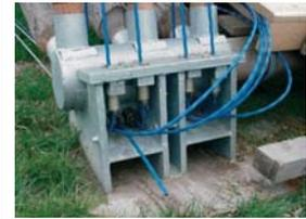
Placa de base do ponto de ancoragem para oito cabos de protensão.
