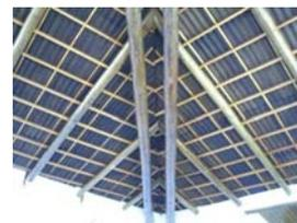
Estrutura da cobertura c/ duas vigas inclinadas principais, e doze vigas inclinadas dispostas em forma de escama de peixe.
