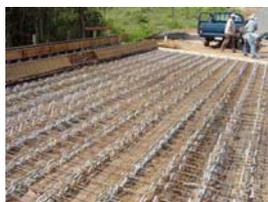
Conectores e malhas de aço, instalados sobre a estrutura de madeira do tabuleiro.
