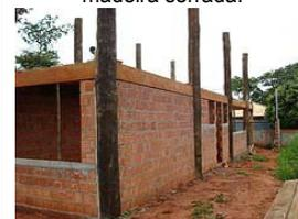
Alvenaria com tijolos furados.
