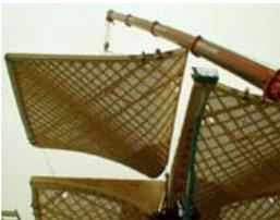
Instalação dos módulos estruturais lamelares da cobertura.
