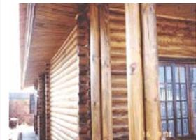
Vista externa: conexões de cantos de paredes.
