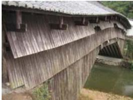
Vista lateral da passarela Houkeng. Nesta passarela em ambos os lados, são cobertas com painéis de madeira de sobreposição, que tem a função de proteção da estrutura, contra intempéries, principalmente da chuva.
