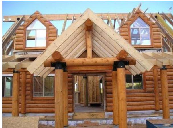
Sistema de pórticos, com vigas fixadas em consoles metálicos.
