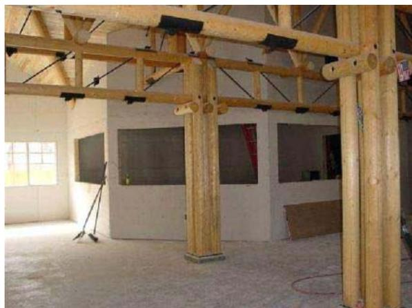
Colunas com seção composta, com quatro peças roliças cada, fixadas sobre a base de concreto.
