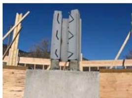
Detalhe das placas de base das colunas.
