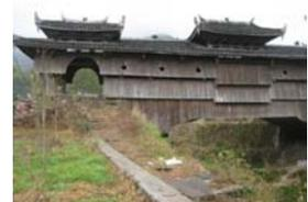
Vista lateral da passarela Rulong. Nesta passarela em ambos os lados, também são cobertas com painéis de madeira de sobreposição, que tem a função de proteção da estrutura, contra intempéries, principalmente da chuva.
