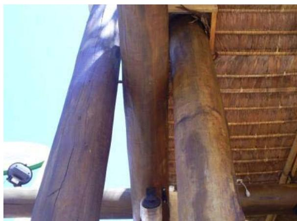
Vista inferior da conexão cujo tipo de ligação é simplesmente um pino metálico unindo à viga às duas colunas que são engastadas no solo.
