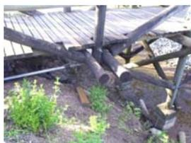
Conexões dos nós das vigas transversinas com seção composta dupla.
