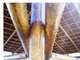
Vista frontal da ligação das vigas intermediárias de travamento, com às colunas.
