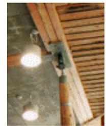
Conexão articulada do topo da coluna inclinada da escora de extremidade.
