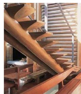
Na sala principal, dois troncos paralelos formam a viga inclinada, que sustentam os degraus da estrutura da escada.
