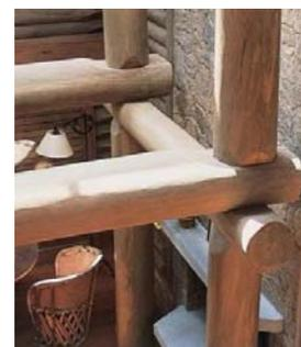
Entalhes precisos, e parafusos nas conexões das peças.
