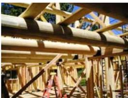
Montagem das vigas do piso do pavimento superior, fixadas através de consoles metálicos.
