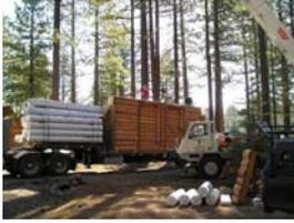
Recebimento na obra, dos painéis pré-fabricados das paredes.
