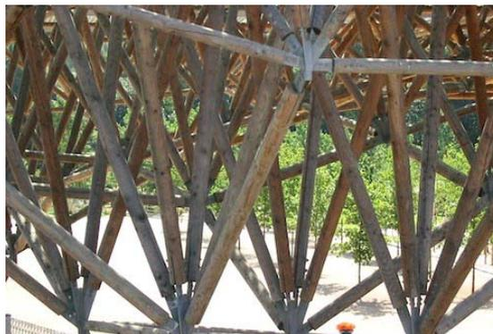
Detalhe da estrutura da treliça espacial com peças roliças de pequeno diâmetro, e das conexões metálicas especiais.
