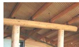
Topos das colunas do pórtico. Estrutura da cobertura com vigas de madeira serrada.
