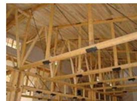
Detalhes das treliças atirantadas da estrutura da cobertura do galpão, e com forro de pinus.
