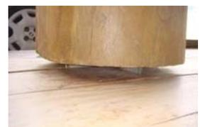
Placa de Base, coluna espaçada do contato com o piso.
