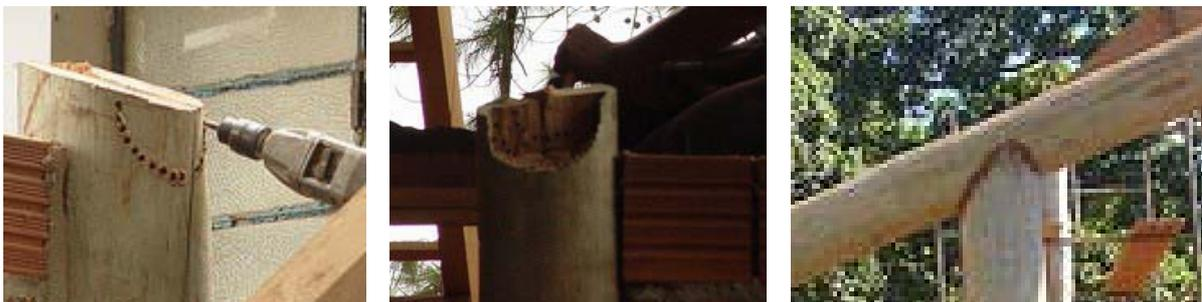
Figura 4.1: Confecção da ligação p/ entalhe, de encaixe cilíndrico, no topo da peça.
