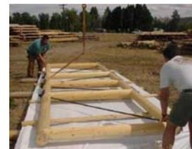
Após montada a estrutura da treliça da cobertura, a mesma é içada por caminhão munck, e posteriormente instalada sobre às colunas.
