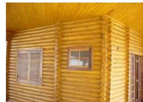
Sistema de conexões de paredes.
