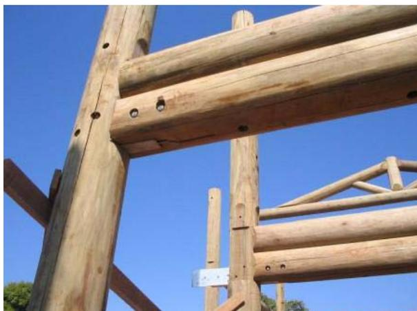
Encontro de vigas duplas com pilar. Ligação com lingueta de aço galvanizado na viga inferior e uma cantoneira na viga superior. A viga é dupla p/ receber carga da laje treliçada.
