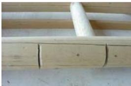
Pequenas fendas transversais na seção da peça roliça, para instalação externa da chapa metálica, de ancoragem da barra de aço de tirante.
