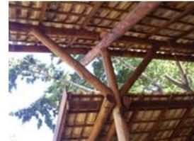
2 Vigas na inclinação da cobertura, que suportam o beiral c/ balanço de 3,5m.
