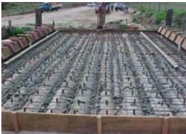
Vista superior do tabuleiro com os conectores metálicos.
