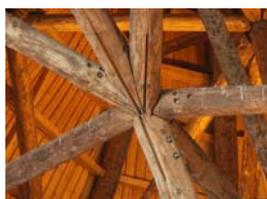
Detalhe da conexão da treliça espacial c/ chapas metálicas internas, barras passantes, arruelas e porcas.
