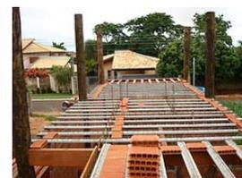
Trilhos das lajes pré-fabricadas treliçadas, apoiadas sobre as vigas serradas, de seção retangular, que compõem o piso do pavimento superior.
