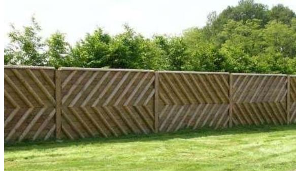
Muro de barreira acústica, c/ colunas de madeira roliça engastadas no solo. Peças inclinadas de madeira roliça para dar rigidez às paredes.
