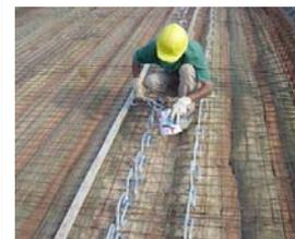
Instalação dos conectores de aço CA50  $\Phi$ 12,5 mm colados c/ adesivo epóxi, em "X", Nas peças de madeira roliça que compõem as longarinas do tabuleiro.
