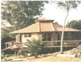
Fundações: Brocas independentes de concreto, sobre pilotis de toras posicionados através de dispositivo metálico, o sistema de barroteamento (16cm sobre viga principal) 22cm recebe o deck (interno) e assoalhos (interno). As ligações estruturais são em cavilhas.
