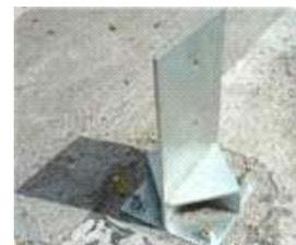
Placa de base de aço galvanizado: transição do bloco de concreto para a coluna de madeira. Foi desenvolvida na Callia Estruturas de Madeira. Este Elemento eleva a coluna de madeira, evitando o contato da mesma c/ o concreto. Com isso a água nesta região evapora rapidamente, evitando o apodrecimento da base da coluna.
