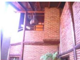
Viga com seção bicircular, porém sem o uso de anéis.
