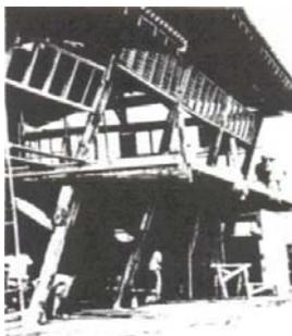
A Alvenaria no pavimento térreo, e no superior é com painel sanduíche de compensado naval. Toda a construção é circundada por uma veneziana de madeira com im de altura a 2,1m do piso.
