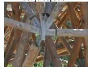
Nó da treliça espacial da cobertura. Detalhe de uma conexão metálica, com parafusos passantes, arruelas e porcas.
