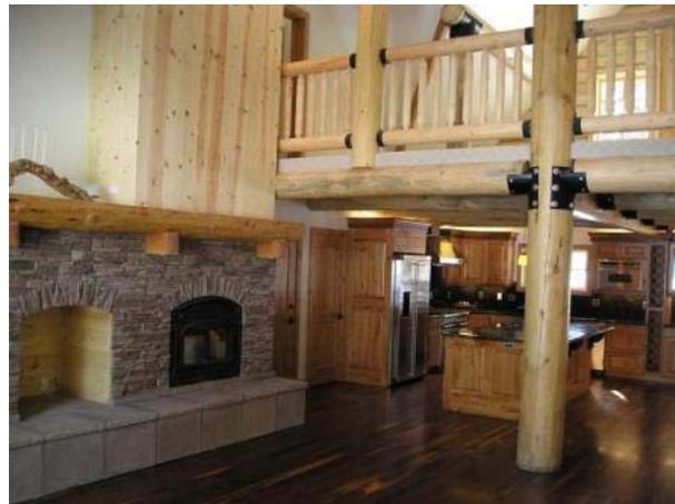
Mesainho: consoles metálicos fixando às vigas nas colunas.
