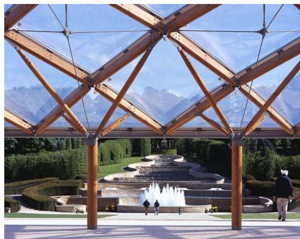
Colunas e escoras inclinadas em V, definitivas de suporte da cobertura com sistema estrutural lamelar com peças de madeira serrada.
