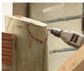
Furação para a confecção da ligação por entalhe, para encaixe da viga de madeira roliça, no topo da coluna.
