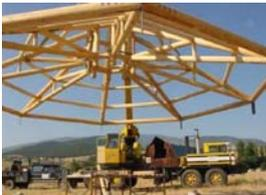
Após montada a estrutura da cobertura, a mesma é içada por caminhão munck, e instalada sobre às colunas.
