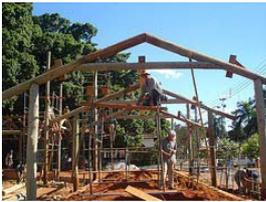
Estruturas dos galpões com sistema estrutural tipo pórtico.
