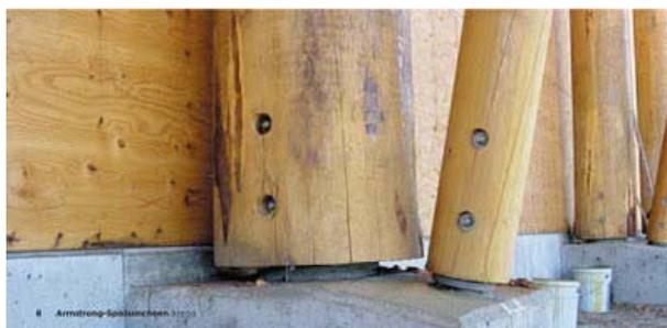
das colunas de madeira roliça de pinus, com placas de base de aço galvanizadas, junto ao bloco de fundação de concreto armado.
