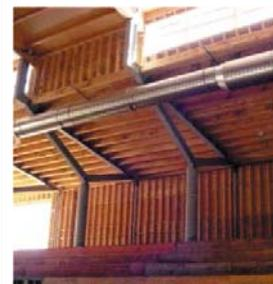
Vista interna da arena: vigas com perfis i de aço, apoiadas em colunas de concreto armado.
