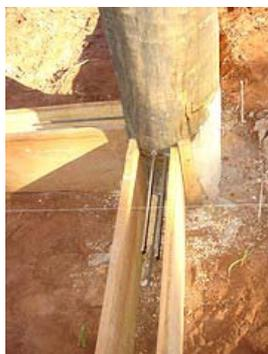
Vigas baldrame: esperas de barras de Aço CA50, coladas com adesivo epóxi, nos furos na base da coluna.
