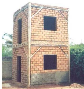
b) Estrutura do pórtico com fechamento em alvenaria cerâmica
