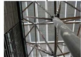
Vista inferior da estrutura de treliça espacial da cobertura, fixada no topo da coluna de concreto armado, situada ao lado direito da edificação.
