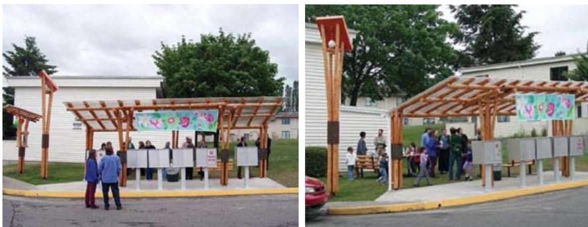
Figura 5.43: Cobertura em balanço, para pontos de ônibus de linhas urbanas, construída em Washington. À esquerda, detalhe do poste de iluminação com peças roliças de pequeno diâmetro. Fonte: USDA.
