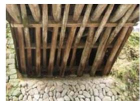
Internamente ao plano das vigas inclinadas, existe um sistema de contraventamento em X com peças roliças de madeira. As peças roliças de madeira são engastadas nas bases, próximas a parede de ciclope de pedras, de contenção de terra.
