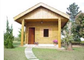
Estrutura da varanda: colunas com peças roliças de seção composta tripla.
