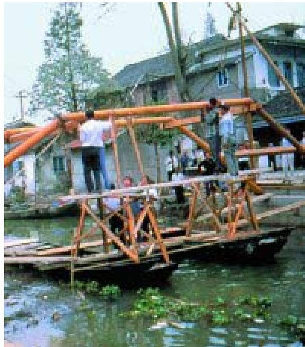
Os construtores da réplica da ponte Rainbow, montaram inicialmente os dois pórticos extremos, para formar a primeira camada que compõem o arco, com três peças roliças cada, apoiando-se em cavaletes a bordo de duas canoas, como simulação do recurso que era utilizado no século XII.
