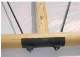
Chapa metálica externa para ancoragem de duas barras de aço de tirante.
