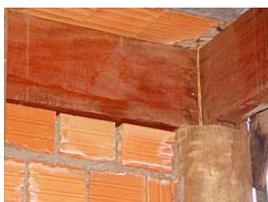
Laje pré-fabricada apoiada sobre as vigas de madeira serrada. Conexão de duas vigas de madeira serrada, apoiadas no corte do poste.
