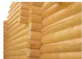
Encaixe na união das paredes de extremidades.
