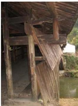
Vista interna da estrutura do pórtico de cobertura da passarela Houkeng. Colunas de madeira roliça, vigas de madeira serrada.
