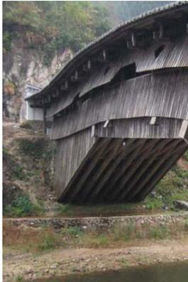
Vista inferior à esquerda da passarela Houkeng. As peças roliças de madeira são engastadas nas bases, próximas a parede de ciclope de pedras, de contenção de terra.
