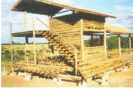
Fechamento com painéis de ossatura de eucalipto serrado revestidos por chapas de compensado lambris de pinus tratado, e em toras de eucalipto sobrepostas, outros componentes como, forros, assoalhos batentes, portas e janelas em eucalipto serrado.
