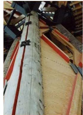
Cortes longitudinais nas colunas. Ligações das seções das colunas, com conexões metálicas, parafusos e porcas.
