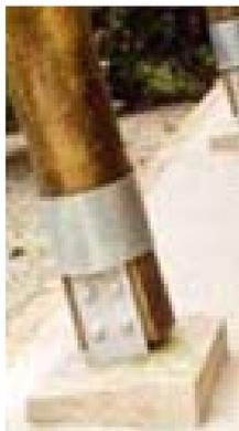
Para garantir a durabilidade das colunas estruturais de madeira roliça, nas ligações entre as colunas e os blocos de fundação, criou-se placas de base em aço galvanizado, parafusadas nas bases das colunas, e chumbadas nos blocos de concreto. Desta forma, isolam-se as peças de madeira para proteger da ação da umidade presente no solo.
