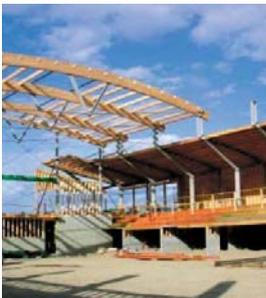
**Instalação das vigas curvas de Madeira Laminada e Colada de pinus que compõem a cobertura.**
