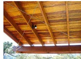
Contraventamentos horizontal, c/ cabos de aço.
