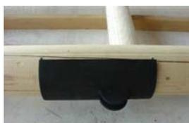
Instalação da chapa metálica externa de ancoragem da barra de aço do tirante.
