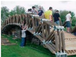
Montagem da treliça em arco, com os segmentos de elementos estruturais de peças roliças de madeira, nos conectores especiais.
