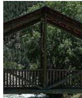
As ligações entre elementos estruturais, são realizadas através de chapas metálicas perfuradas pregadas, parafusos metálicos. Todos os detalhes de conexão extremidade inferior dos postes estão inseridos dentro de cavidades usinadas no topo e na extremidade inferior da peça.
