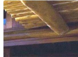
Viga secundária, apoiada normalmente através de entalhe e pino metálico, lateralmete na viga principal.
