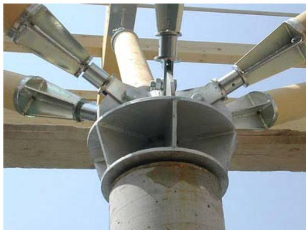
Placa de base metálica, fixada no topo da coluna de concreto armado.
