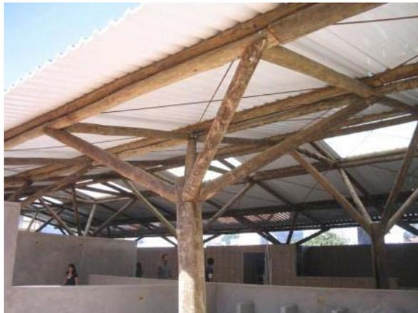
Sistema estrutural em árvore com peças roliças de madeira de pequeno diâmetro, apoiadas nas colunas.
