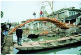
Após a montagem dos dois pórticos, iniciou a montagem de tal maneira a conceber a forma do arco. Depois de concebida a forma do arco, os dois pórticos iniciais foram removidos. O autor e membros da equipe ensaiaram a resistência inicial nas bases.
