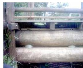
Vigas com peças roliças de madeira, com seção Bicircular, utilizando anéis de aço, barras rosqueadas, parafusos, arruelas e porcas.
