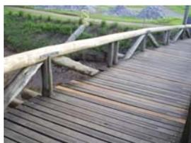
Guarda corpo que compõem os contraventamentos em X da estrutura treliçada da passarela.
