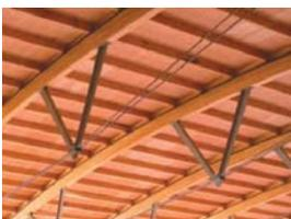
**Tirantes com cabos de aço duplo de Ø35mm de diâmetro.**
