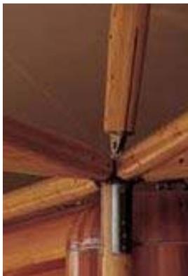
Conexões metálicas especiais, que unem os elementos estruturais de madeira roliça.
