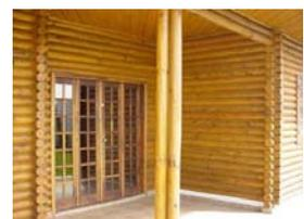
Colunas de peças roliças, com seção composta tripla e vigas com seção composta dupla
