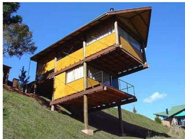
Loft na encosta. Colunas sobre blocos de concreto.
