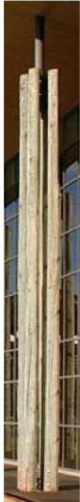
Coluna composta com quatro postes de eucalipto.
