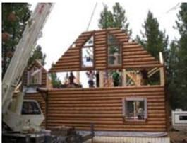
Instalação do painel da estrutura que compõe a inclinação da cobertura, sobre a parede já instalada.
