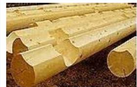
Entalhes para conexões nos encontros de paredes, de construções com sistemas estruturais tipo Log Homes.
