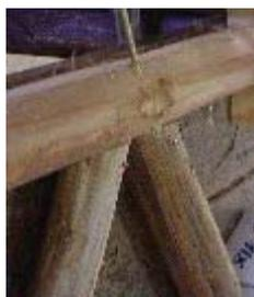
Instalação do pino metálico, inserido transversalmente, nos elementos estruturais.
