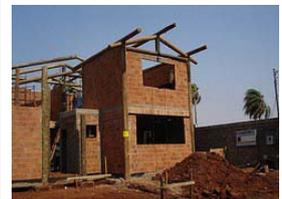
Alvenaria com tijolos furados.
