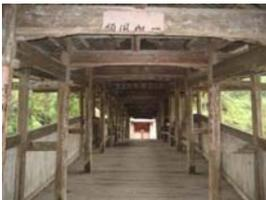
Vista interna da estrutura do pórtico de cobertura da passarela. Colunas de madeira roliça, vigas de madeira serrada.
