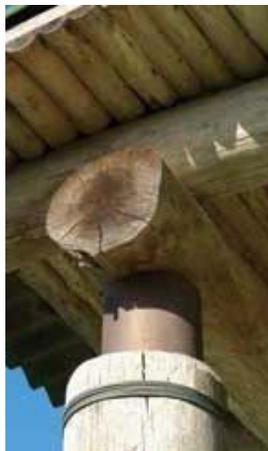
O topo e a base das colunas são afinados e revestidos com uma cinta de cobre patinável para maior proteção, além de terem suas fibras amarradas para evitar aberturas.
