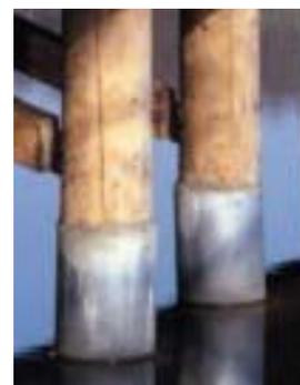
Parte das colunas submersas são protegidas com impermeabilização, a fim de aumentar a vida útil.
