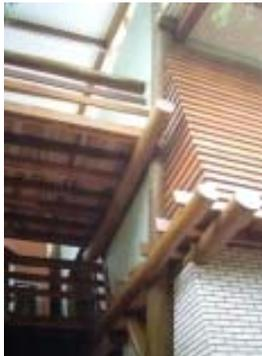
Detalhe lateral da viga dupla que suporta a estrutura do 1º piso, fixadas na coluna inclinada.
