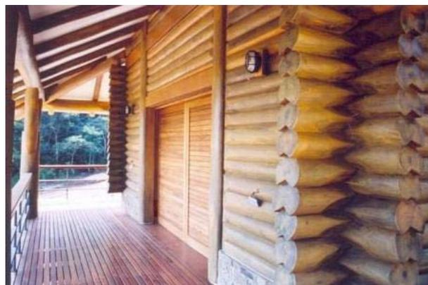
Duas demãos de impregnante do tipo stain (Osmocolor, da Montana Química) protegem o madeiramento. Ele deve ser reaplicado a cada dois anos. 'Assim, o eucalipto pode durar tanto quanto uma parede de alvenaria', diz Lupércio Barros Lima, da construtora Tora.
