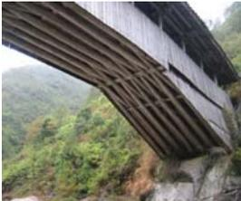
Vsita inferior da passarela. A s bases da estrutura desta passarela são esgastadas diretamente na rocha sã.
