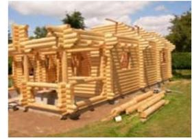
Após realizada as obras de fundações, normalmente de concreto armado, são montadas as peças de madeira roliça, que formam os painéis das paredes estruturais.
