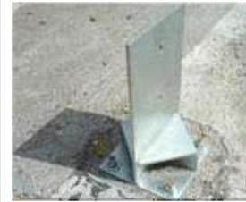
Segundo CALLIA (2009), este é o detalhe de número 1 da série de detalhes. É uma base metálica para coluna que serve como transição do concreto para a madeira. Esta base metálica, galvanizada à fogo, foi desenvolvida na CALLIA ESTRUTURAS e possui algumas características especiais.
