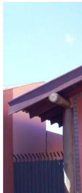
Conexão viga-coluna, viga apoiada no topo da coluna e interligada com pino metálico de vergalhão de aço CA50.
