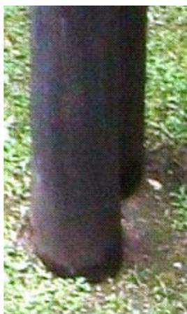
Umidade nas bases das colunas.
