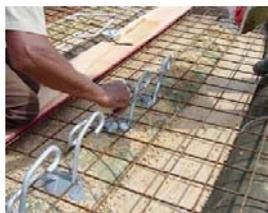
Instalação dos conectores de aço CA50  $\Phi$ 12,5 mm colados c/ adesivo epóxi, em "X", Nas peças de madeira roliça que compõem as longarinas do tabuleiro.
