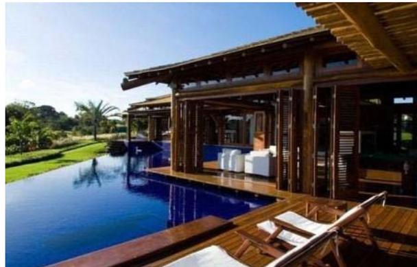
Estrutura da sala: Sistema estrutural viga-coluna.
