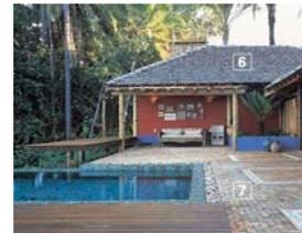
6. Muito usadas no litoral da Bahia, as telhas de madeira (taubilha) 20cmx50cm, foram fixadas na estrutura da cobertura com pregos galvanizados. A manta da subcobertura é obrigatória para evitar infiltrações. Foram cortadas em tiras e colocadas nos trechs em que as telhas sobrepõem.
