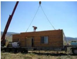
Posicionamento e montagem dos painéis pré-fabricados das paredes, com auxílio de um caminhão guindaste.
