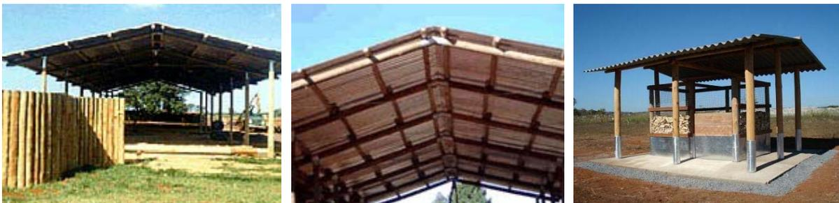
Figura 5.3: Galpões tipo pórtico, para armazenagem de produtos rurais. Fonte: [www.gangnail.com.br](http://www.gangnail.com.br)
