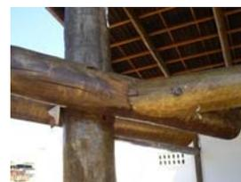
Vista lateral da ligação das vigas intermediárias de travamento, com às colunas.
