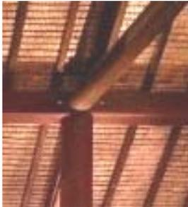
Conexão da coluna de madeira roliça e vigas de madeira roliça e serrada.
