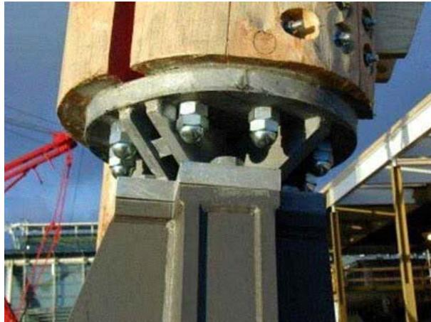
Detalhes das ligações da placa de base, de uma das colunas das torres.
