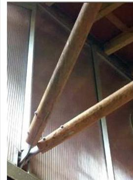
Detalhe da conexão das bases das escoras da estrutura da cobertura e do pórtico em arco inclinado da fachada principal.
