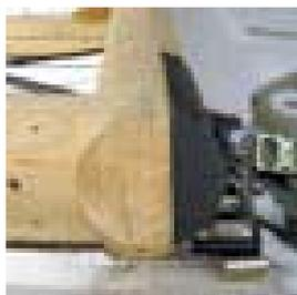
Chapa metálica externa de canto, para ancoragem da barra de aço do tirante.
