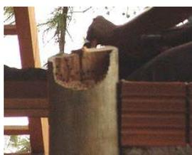
Confecção do entalhe, para encaixe da viga de madeira roliça, no topo da coluna.
