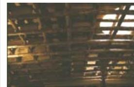
Detalhe do sistema estrutural de grelha da cobertura, com peças de madeira roliça de pequeno diâmetro (9 cm).
