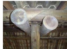
Conexão das 2 Vigas na inclinação da cobertura.
