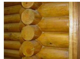
Sistema de conexões de paredes.
