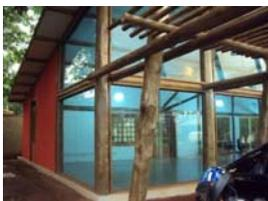
Vigas com seção composta dupla, fixadas nas colunas, com barras de aço rosqueadas passantes, arruelas e porcas.
