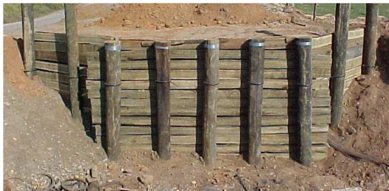
Figura 5.7: Muro de contenção de terra. Fonte: CALIL (2007).
