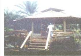
Fechamento: Esquadrias de vidro posicionado entre os pilares e parte inferior em toras sobrepostas encaixadas também entre os pilares.
