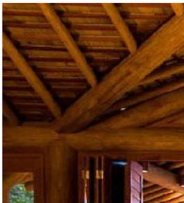
Conexão da estrutura da varanda com a sala.
