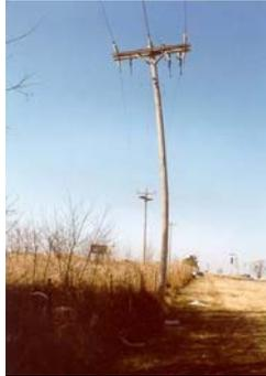
Figura 2.5: Poste com curvatura simples acentuada. Fonte: CALIL (2007).
