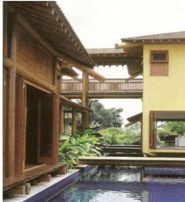
Suspensa do solo por meio de palafitas, a casa se livra de umidade. A altura também melhora a ventilação.
