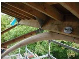
Vista lateral dos detalhes das escoras de madeira roliça de pequeno diâmetro, que suportam a estrutura da cobertura e do pórtico em arco inclinado da fachada principal.
