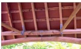
Vista inferior dos detalhes das escoras de madeira roliça de pequeno diâmetro, que suportam a estrutura da cobertura e do pórtico em arco inclinado da fachada principal.
