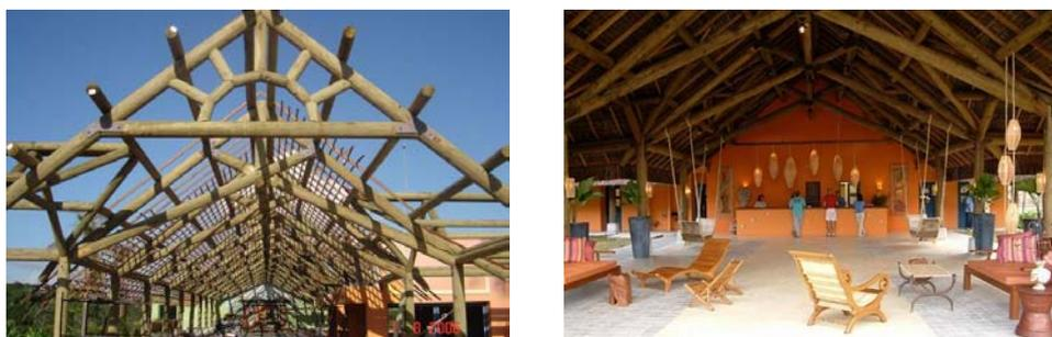
Figura 5.38: Estrutura da cobertura interna do galpão, com treliças scissors. Fonte: [www.callia.com.br](http://www.callia.com.br)
