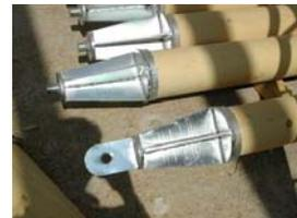
Conexões metálicas galvanizadas: articulações nas extremidades das escoras.
