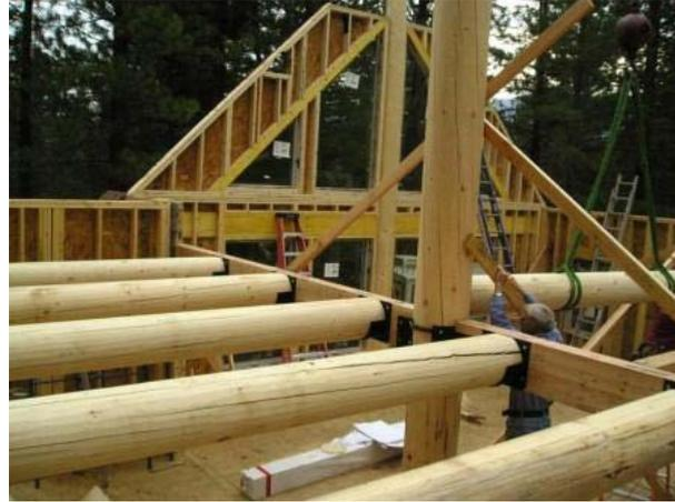
Vigas de madeira roliça, apoiadas em consoles metálicos, fixados nas vigas de madeira serrada.
