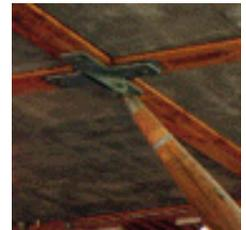
Conexão articulada do topo da coluna inclinada da escora central.
