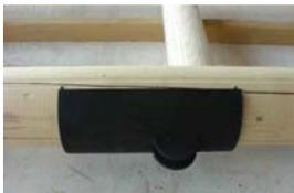
Instalação da chapa metálica externa de ancoragem da barra de aço de tirante.
