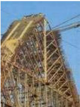
Cimbramentos do cume do Viaduto Mülmisch Talbrücke. Sistema estrutural com coluna central e diagonais tipo escama de peixe.
