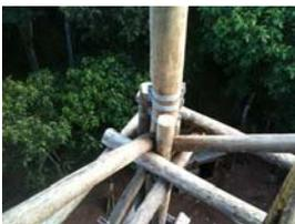
Detalhe da conexão de transição, de uma das colunas de seção composta por quatro peças, para uma seção simples, com uma peça de madeira roliça.
