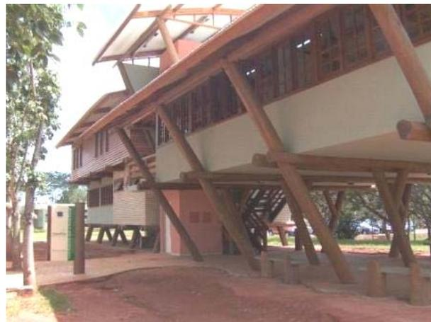
Estrutura com vigas duplas e colunas inclinadas.
