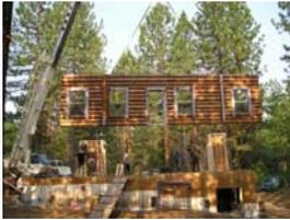
Íçamento dos painéis pré-fabricados das paredes, com auxílio de um caminhão guindaste.
