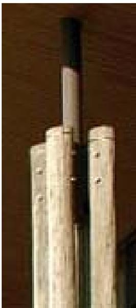
Conexão no topo da coluna de eucalipto composta de quatro postes e a interface com a estrutura metálica com perfis tubulares.
