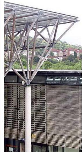
Detalhe da estrutura de treliça espacial da cobertura, fixada no topo da coluna de concreto armado, situada ao lado direito da edificação.
