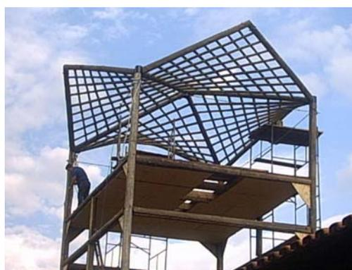
b) Cobertura transferida e montada no pórtico
