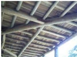
Peças roliças da grelha que compõem a estrutura do piso, apoiadas sobre às vigas secundárias, que transferem às cargas verticais para as vigas principais e estas para as colunas.
