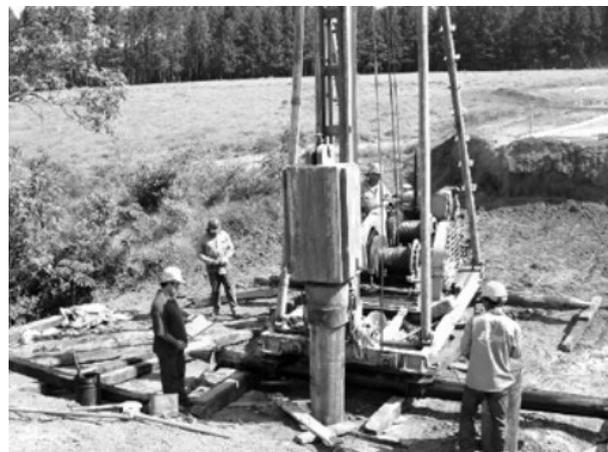
Cravação da estaca: martelo sobre o capacete no topo da estaca.
