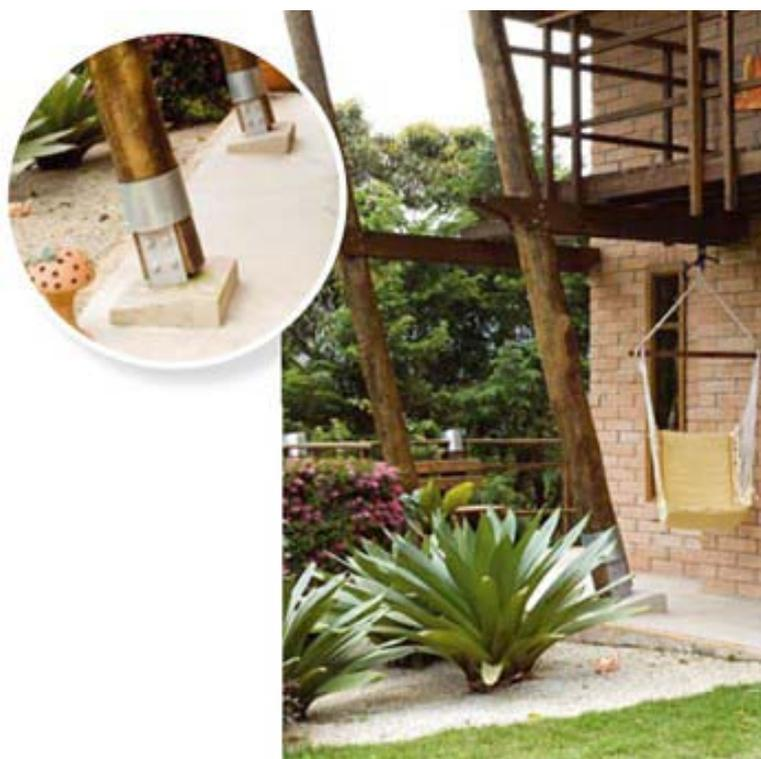
Figura 4.35: Placas de base de aço galvanizado chumbadas no bloco de fundação. Fonte: AMÁ (2009).
