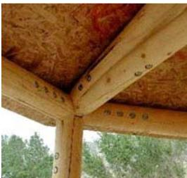
Conexão com chapas internas na ligação vigas-coluna-banzo superior. E barras de aço rosqueadas passantes na ligação do banzo inferior com o banzo superior.
