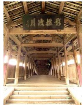
Vista interna da estrutura do pórtico de cobertura da passarela Xidong. Colunas de madeira roliça, vigas de madeira serrada.
