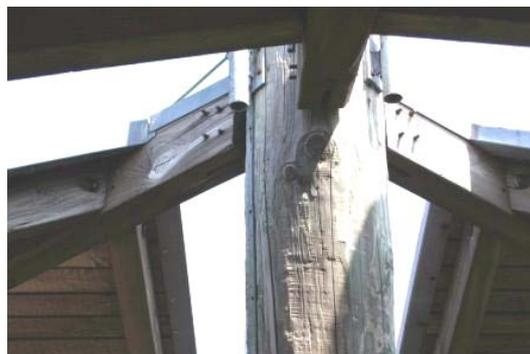
Ligações de Vigas Horizontais com a coluna.
