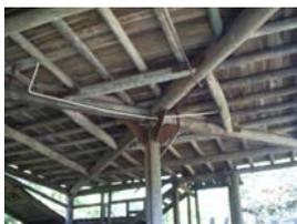
Detalhes das vigas fixadas na coluna central.
