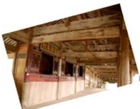
Vista interna da estrutura do pórtico de cobertura da passarela Beijian. Colunas de madeira roliça, vigas de madeira serrada.
