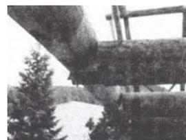
O contraventamento é feito por estrutura transversal no meio do combinando a ação do telhado e piso.
