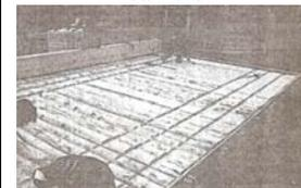
Fase de montagem: instalação das peças semi-circulares de madeira, para formar o pano da laje, e instalações das armaduras.
