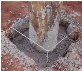
Fundação: Poste engastado em bloco de concreto armado.
